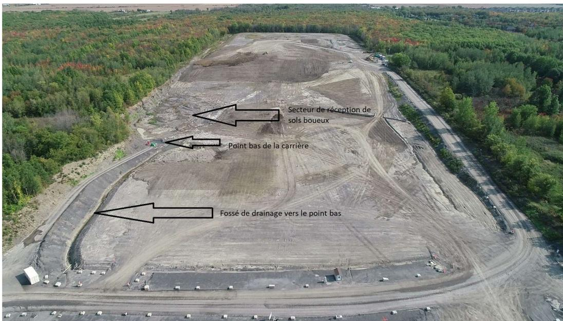
En bas à gauche se trouve une tranchée. Les eaux de précipitation dans la tranchée s'accumulent dans le point le plus bas de la carrière. L'eau est pompée vers les bassins de décantation. Plus haut, se trouve le site de dépôt des sols boueux.
