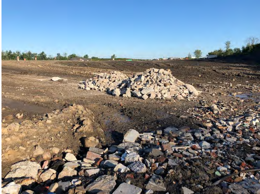
Photographie no. 6: Matériaux de béton et maçonneries
