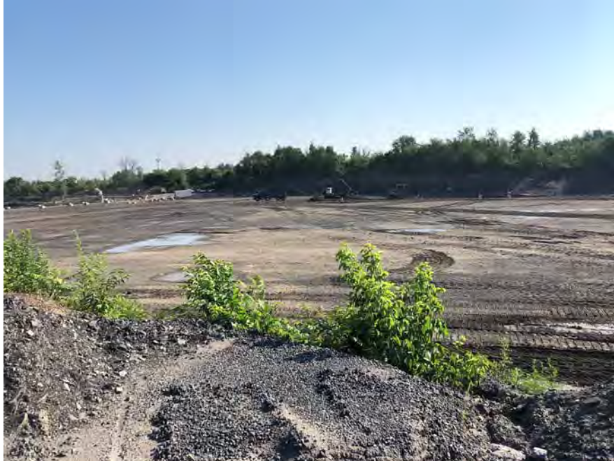
Photographie no. 2: Zone des travaux
