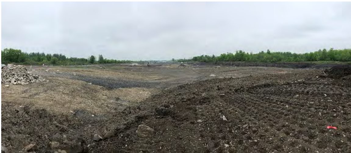
Photographie no. 6 : Vue du Site, zone de remblai
