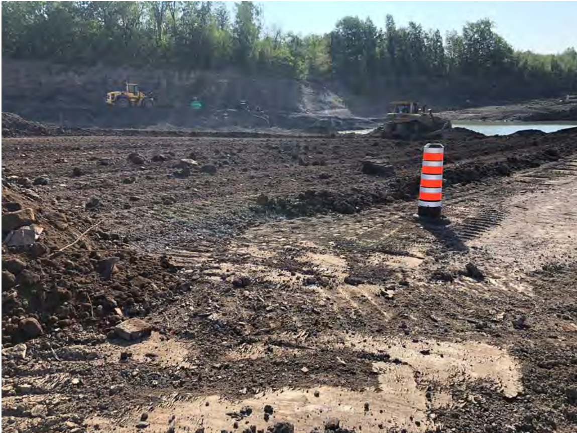
Photographie no. 1: Zone des travaux
