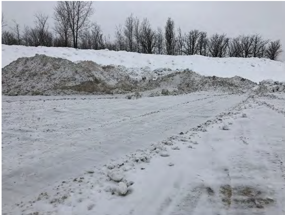
Photographie no. 6 : Neige retirée de la surface des travaux
