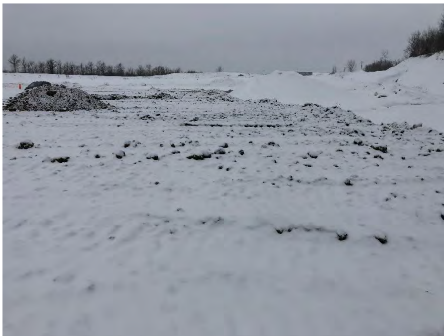
Photographie no. 7 : Travaux de remblai devant le bassin
