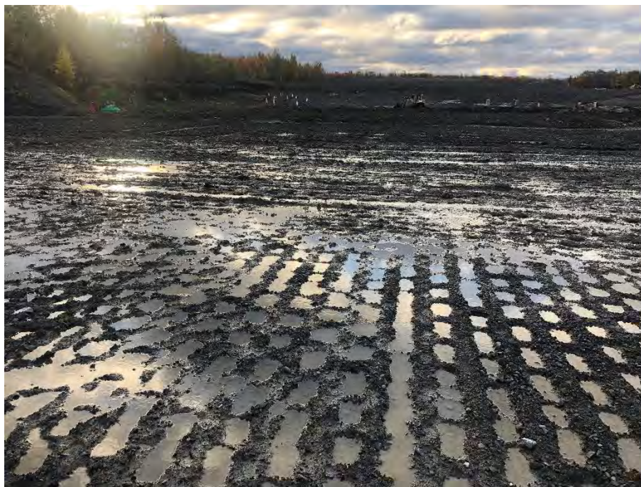
Photographie no. 5: État des sols compactés
