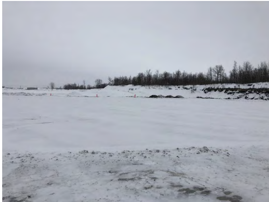
Photographie no. 8 : Vue sur la zone de travaux du bassin
