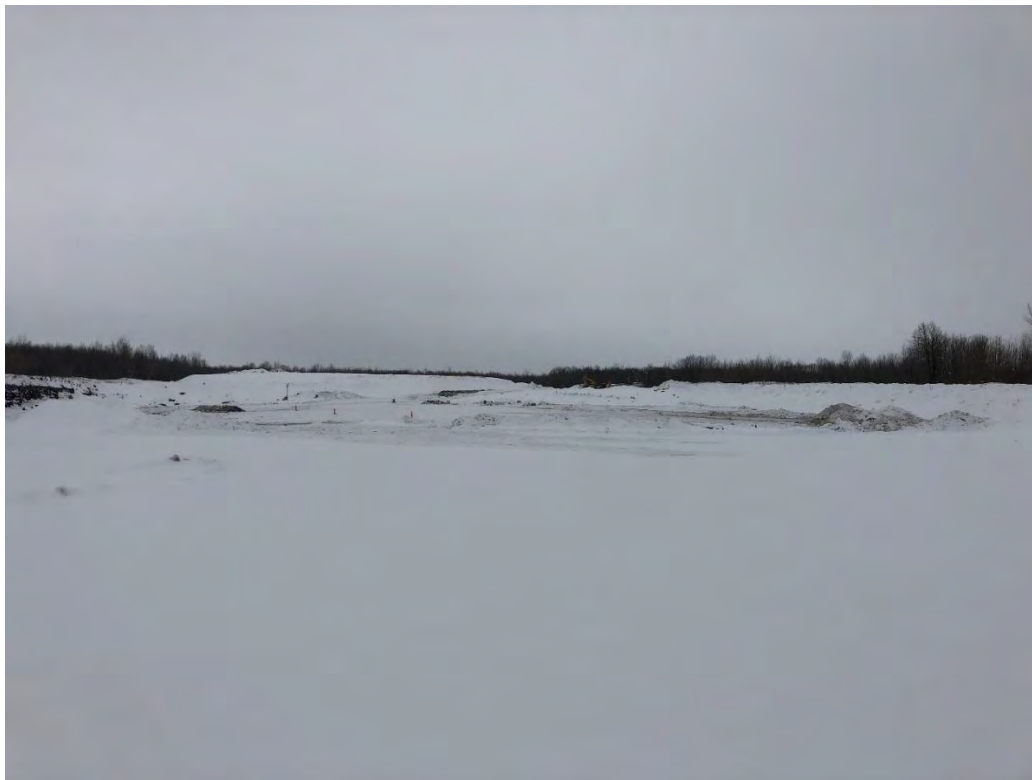
Photographie no. 1 : Zone des travaux
