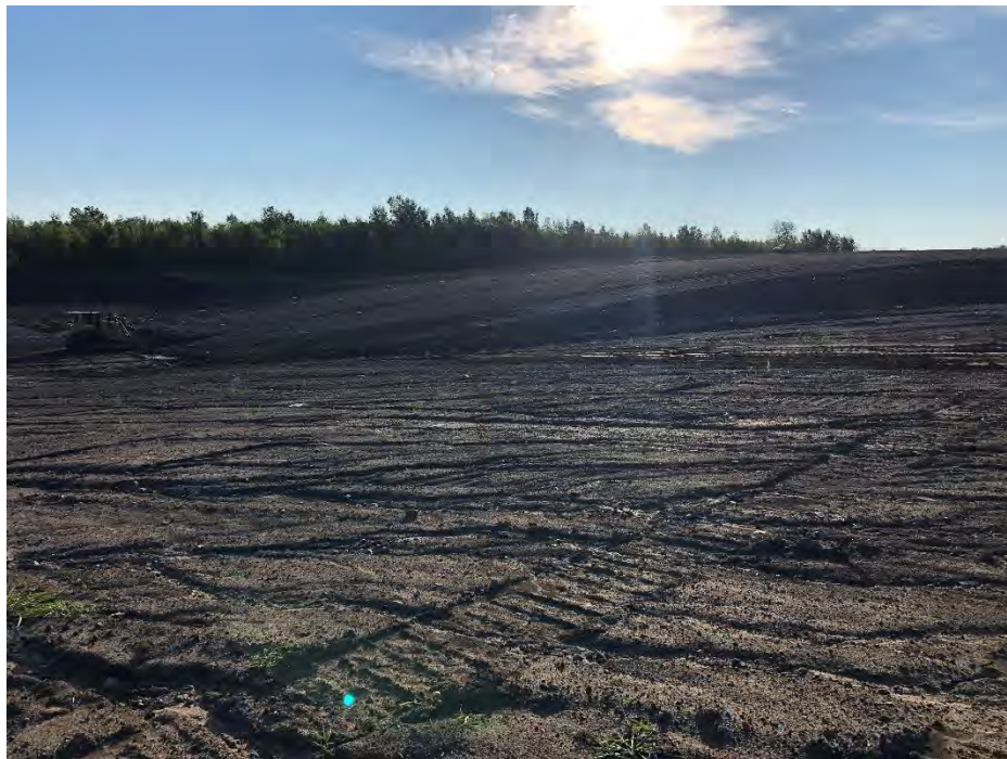
Photographie no. 1: Zone des travaux (Gerled)
