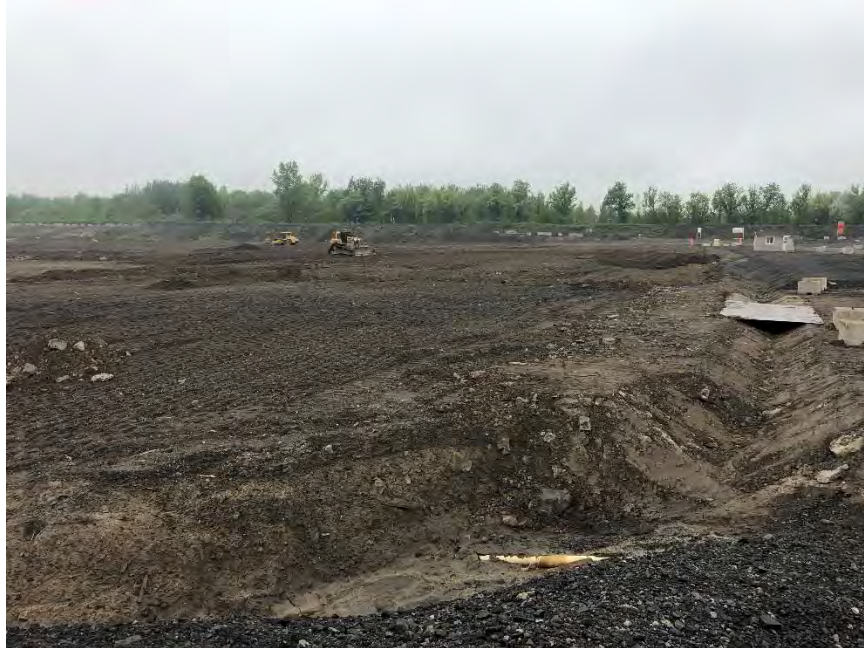
Photographie no. 1: Zone des travaux
