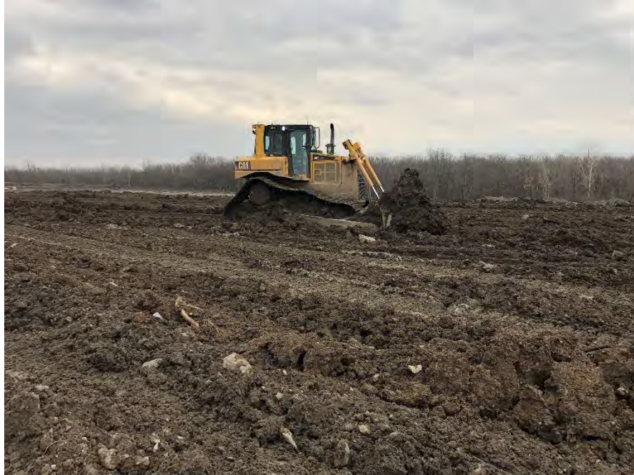
Photographie no. 5: Bouteur (CAT D6T LGP)
