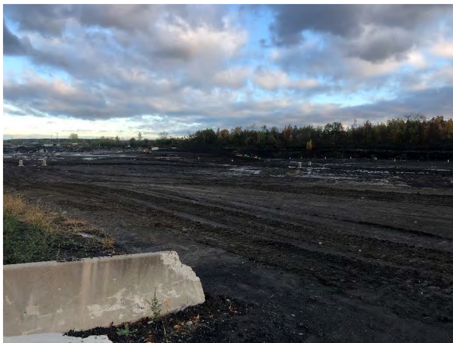
Photographie no. 3: Vue du site
