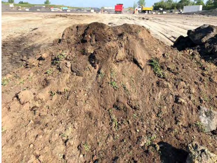
Photographie no. 4: Matériaux Reçus (terre Végétale)
