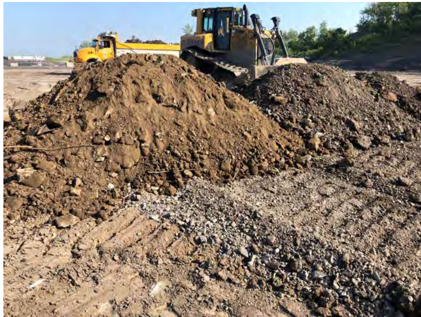
Photographie no. 3: Matériaux Reçus + équipement de mise en place
