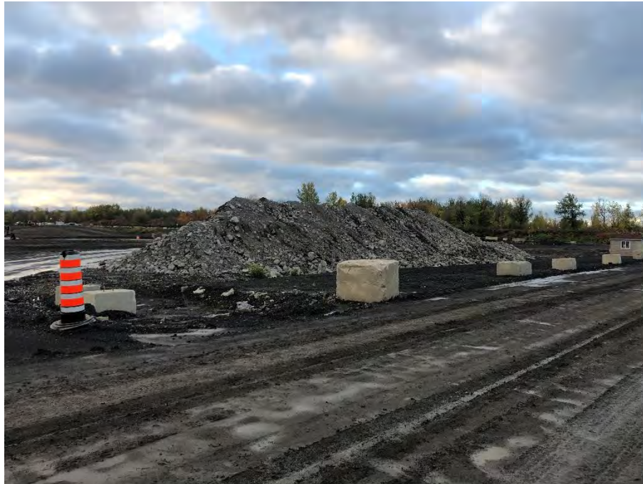
Photographie no. 2: Pile de béton en attente
