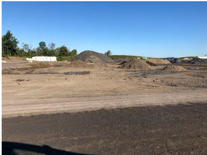
Photographie no. 5: Matériaux Reçus Mis en pile
