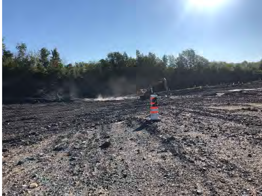
Photographie no. 2: Zone des travaux (Lac)
