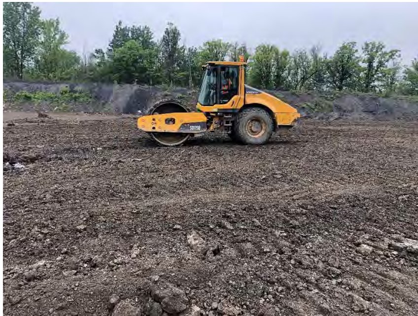
Photographie no. 4: Équipement de compaction
