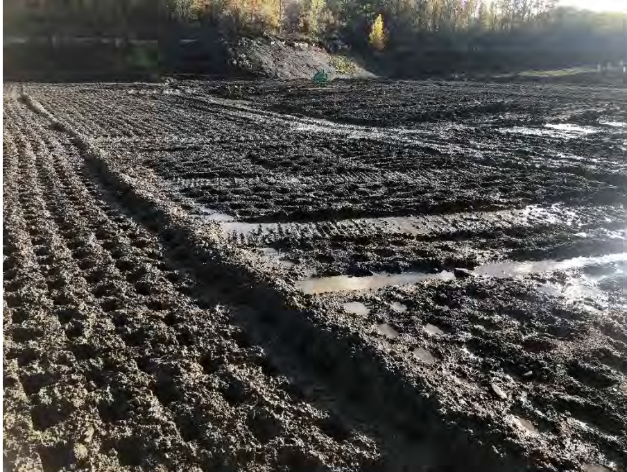
Photographie no. 6: État des sols compactés
