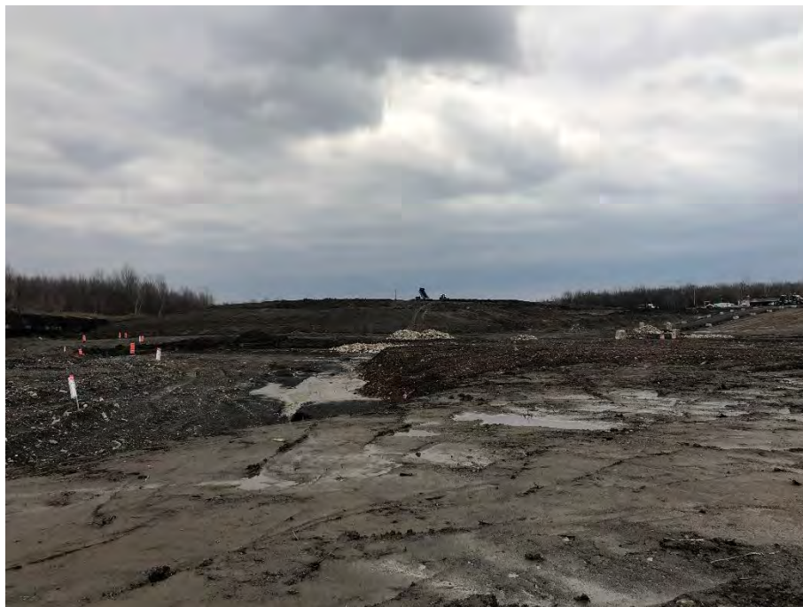
Photographie no. 6: Zone des travaux
