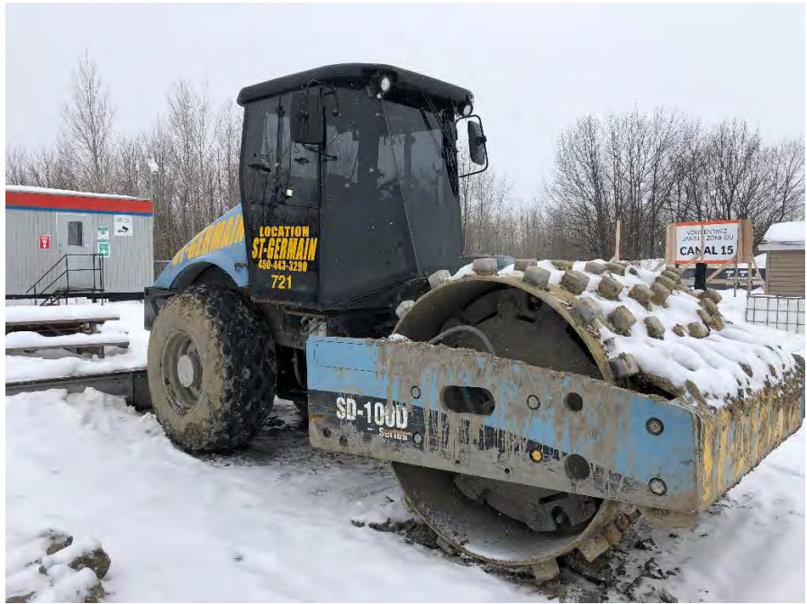
Photographie no. 4 : Équipement de compaction
