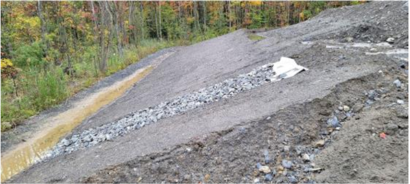
PHOTO 17 : Aménagement définitif du talus (partie nord-est). Section enrochée du système de drainage superficiel (Octobre 2023)
