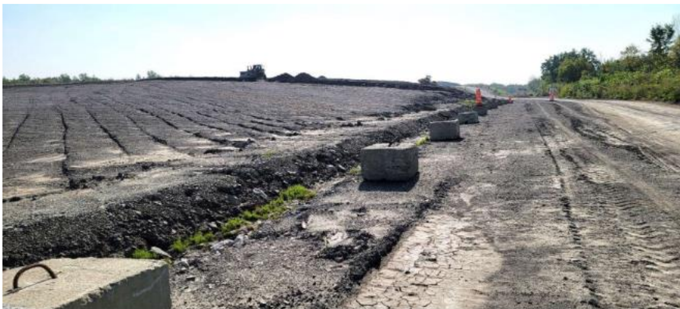
PHOTO 16 : Aire de disposition des sols sur le flanc sud-ouest de la butte (Septembre 2023)
