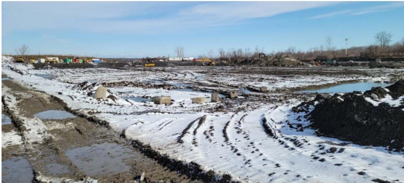
PHOTO 4 : Vue en direction nord-ouest du bassin n° 2 (Mars 2023)
