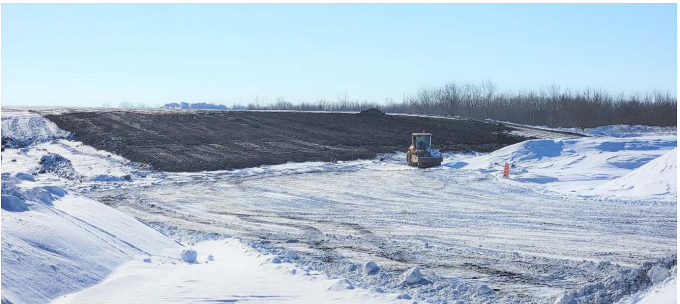
PHOTO 2 : Aire de déchargement des sols importés sur le talus ouest de la butte, nivellement et compaction des sols (Février 2023)
