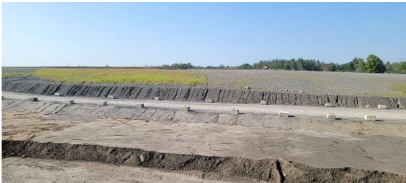
PHOTO 15 : Aperçu du flanc nord de la butte dans sa partie aval (Septembre 2023)
