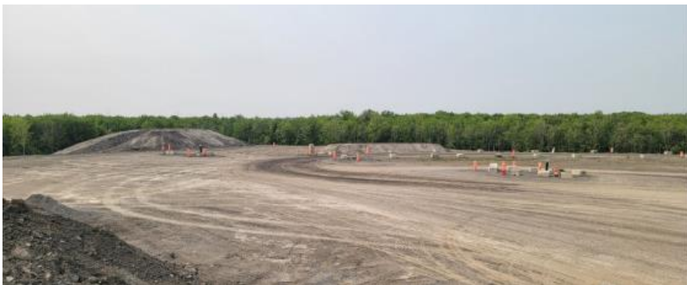
PHOTO 10 : Vue en direction sud-est du sommet de la butte (Juin 2023)
