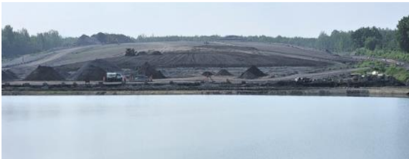
PHOTO 11 : Vue en direction nord du bassin d'eau et des opérations sur le talus ouest de la butte (Juillet 2023)
