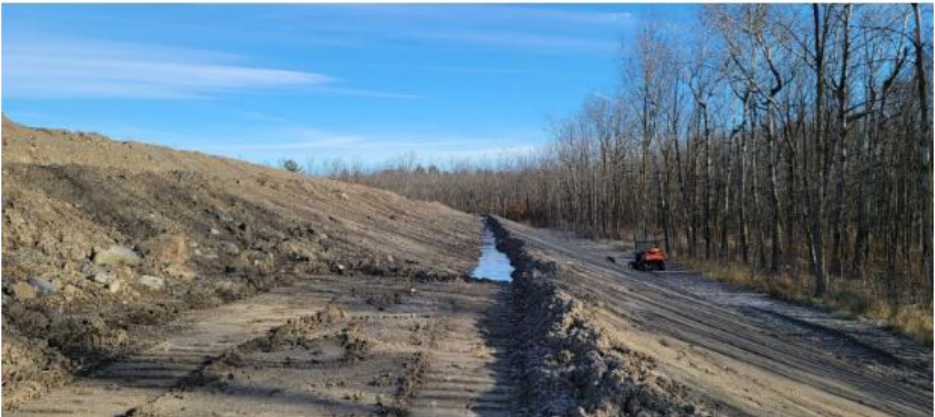
PHOTO 20 : Aperçu du talus sur le flanc est de la butte. En contrebas, section du talus faisant l'objet du terrassement définitif (Novembre 2023)
