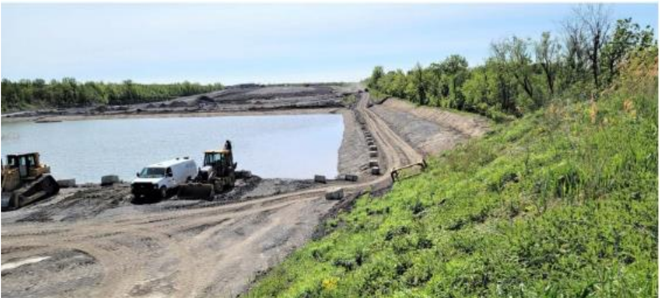
PHOTO 8 : Enlèvement de blocs de béton sur la berge sud du futur plan d'eau (Mai 2023)
