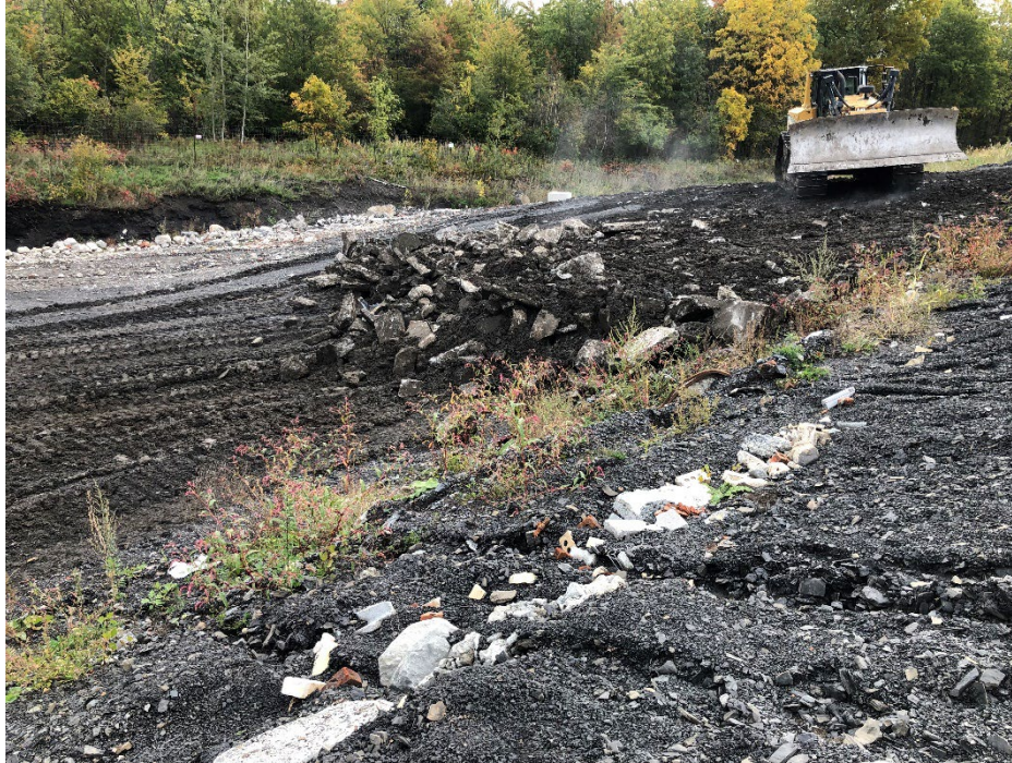
Photographie no. 4: Mise en place du matériel de bloc de béton
