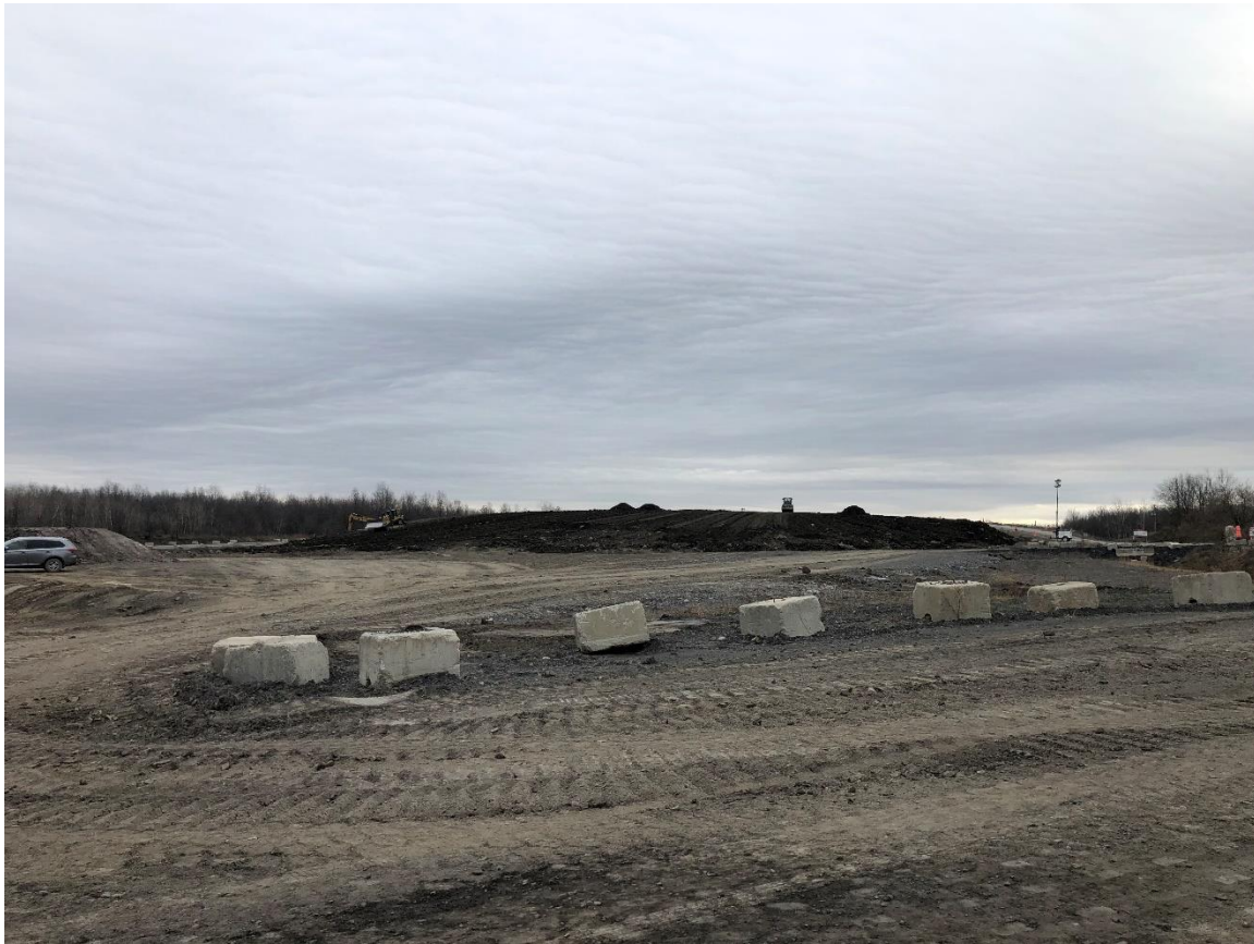
Photographie no. 1: Zone des travaux
