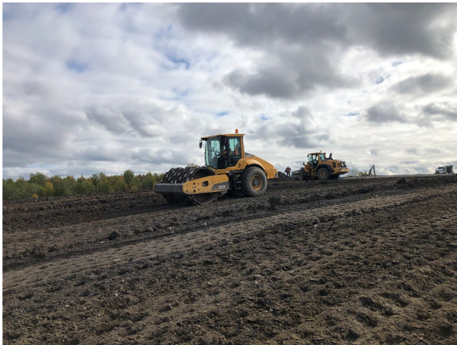
Photographie no. 3: Équipement de compaction
