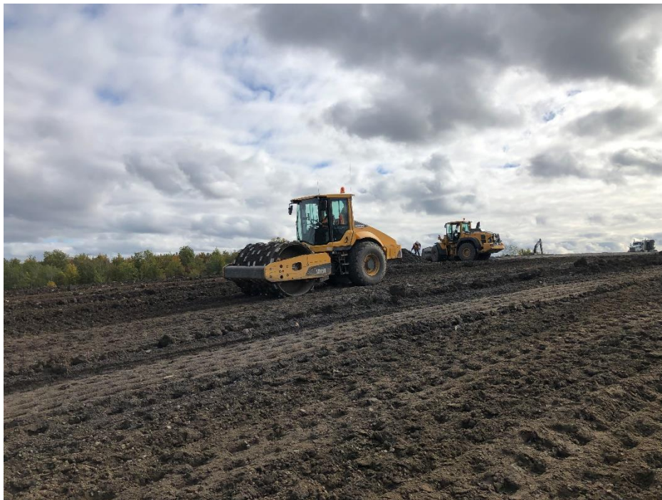
Photographie no. 3: Équipement de compaction
