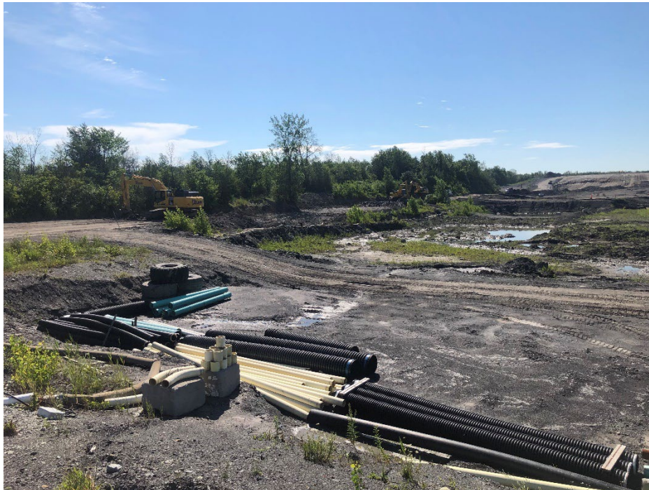
Photographie no. 1: Zone des travaux
