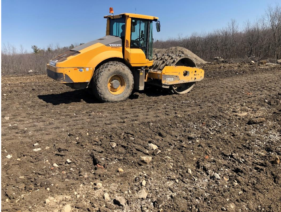
Photographie no. 4: Équipement de compaction
