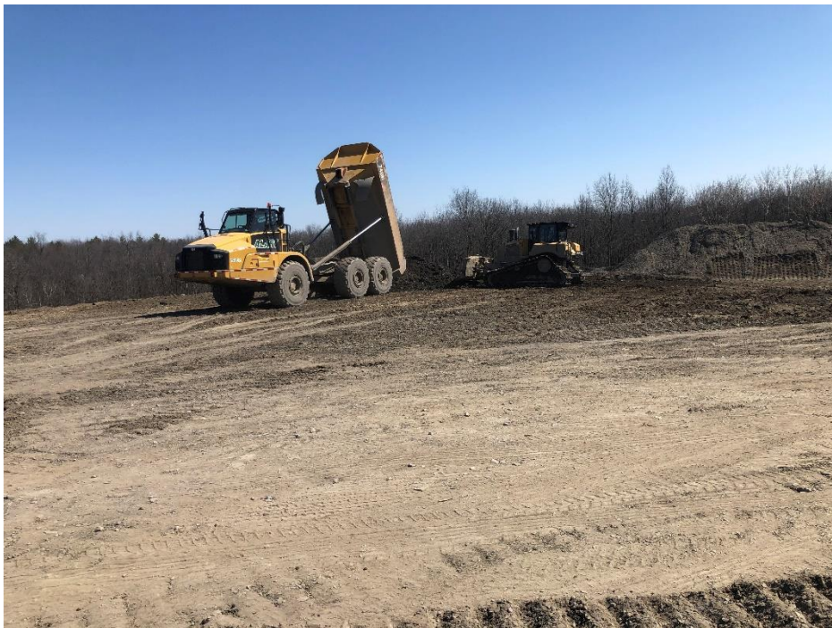
Photographie no. 3: Équipement de mise en place
