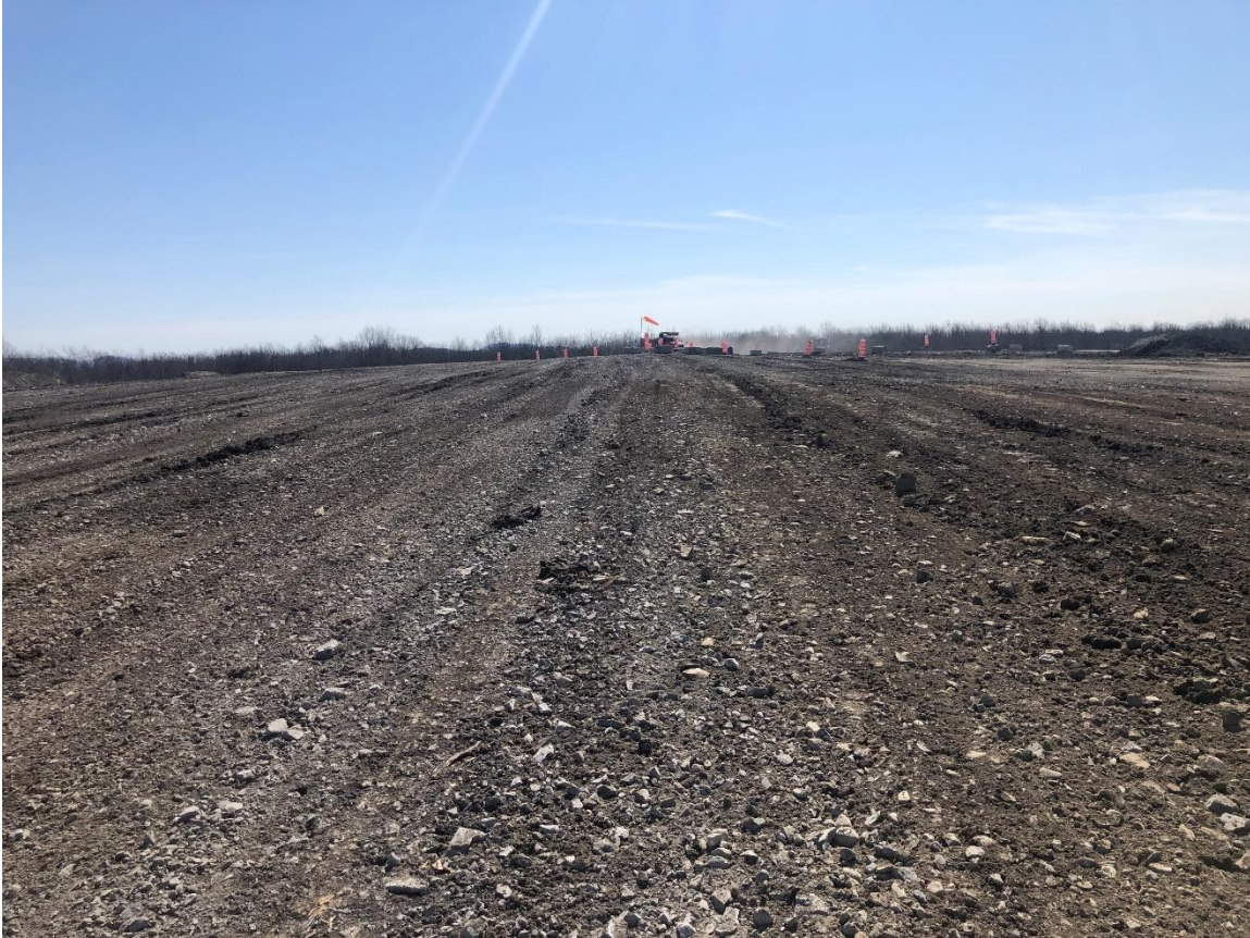
Photographie no. 1: Zone des travaux
