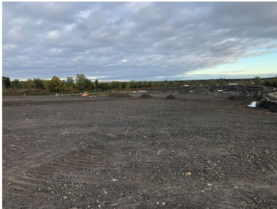
Photographie no. 1: Zone des travaux
